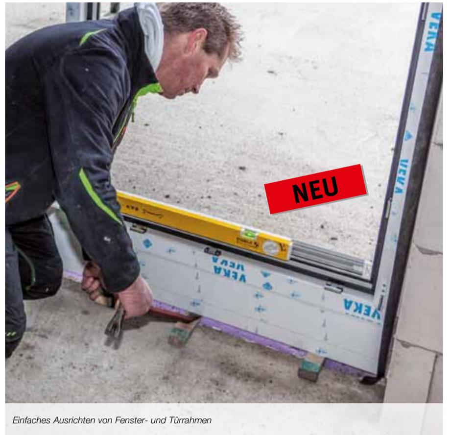
Einfaches Ausrichten von Fenster- und Türrahmen
