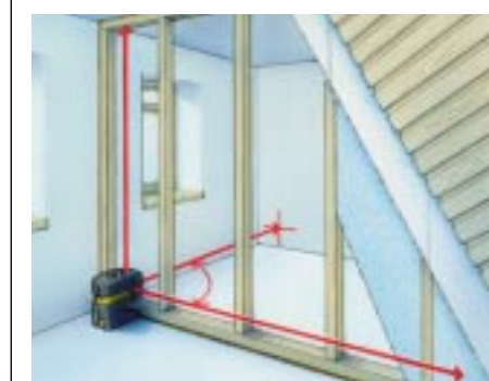
Innenausbau-Elemente lotrecht, in der exakten Verlängerung und im rechten Winkel zueinander verlegen.
